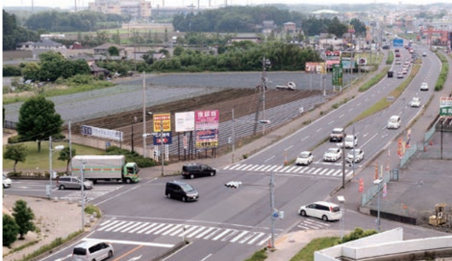
4車線化された国道245号
