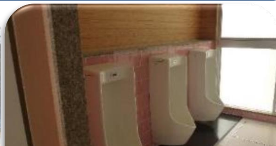
小・中学校のトイレの改修
