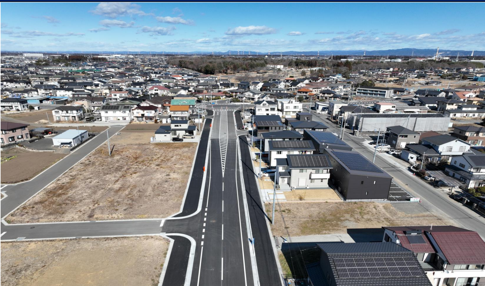
📷令和7年3月供用開始の中根六ッ野線（北側）（令和7年3月撮影）
