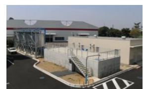
上ヶ砂配水場
