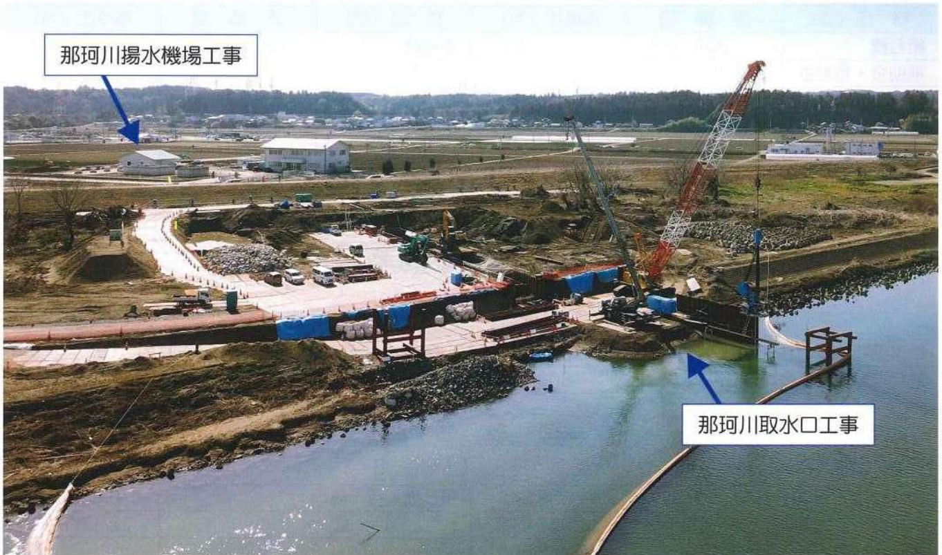
水戸市飯富町：造成中の那珂川取水口（手前）と那珂川揚水機場（奥）
