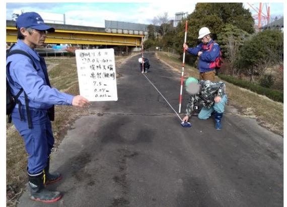
堤防の亀裂を測定する様子
