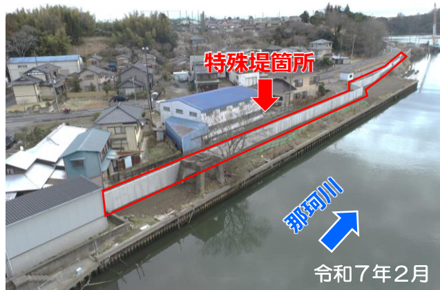
特殊堤（コンクリート擁壁）施工状況 （ひたちなか市栄町地先）
