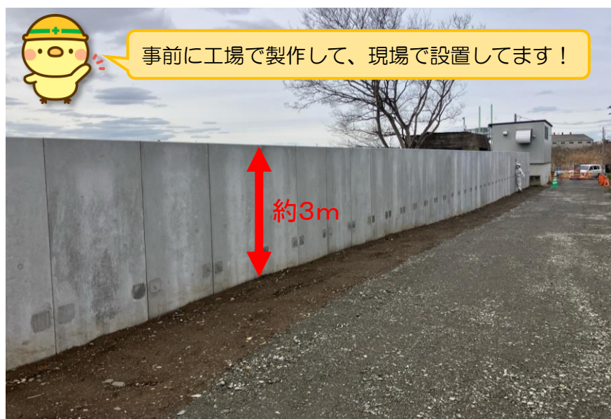
特殊堤（コンクリート擁壁）施工状況 （ひたちなか市栄町地先）
