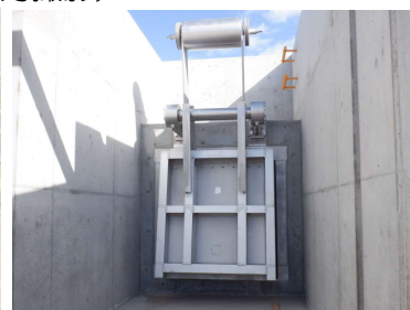
フラップゲート設置状況
