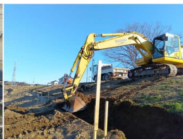
築堤盛土の準備
