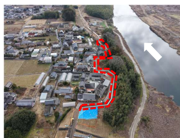
工事箇所の全景（上流から）
