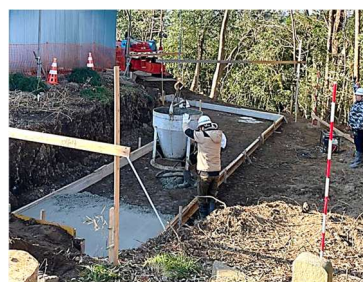
基礎コンクリートの打設
