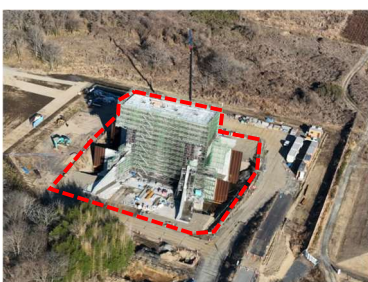
工事箇所の全景（河川側から）
