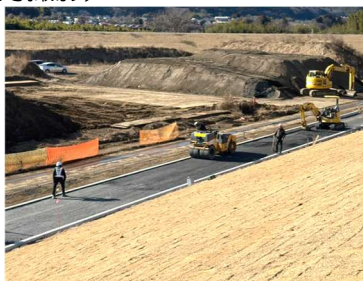
管理用通路の舗装
