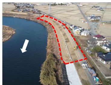
工事箇所の全景（下流から）
