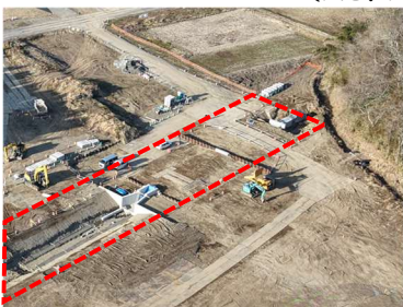
工事箇所の全景（下流から）
