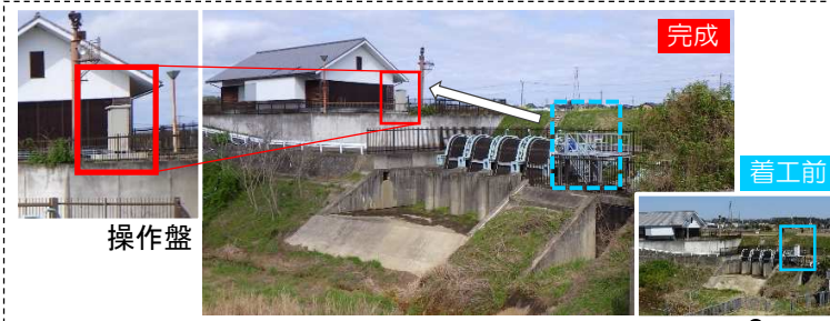
境川排水機場：操作盤の移設
