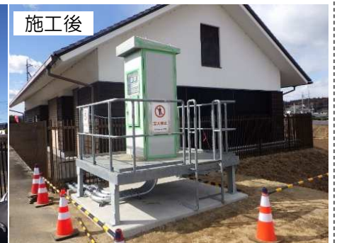
西田川排水機場
