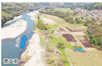
茂木町河井上地先 那珂川右岸51.0k付近
