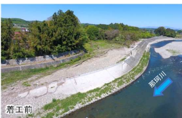
那珂川町谷田地先 那珂川右岸79.5k付近
