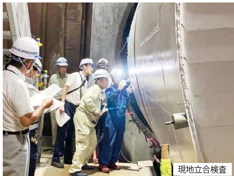
完成したシールドマシン
