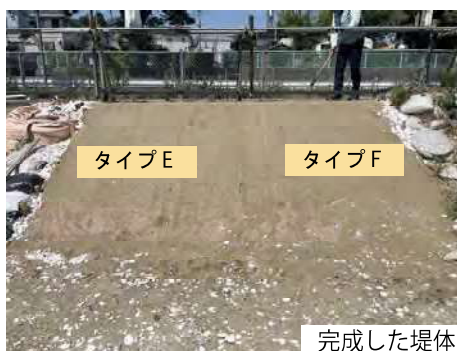
完成した堤体
