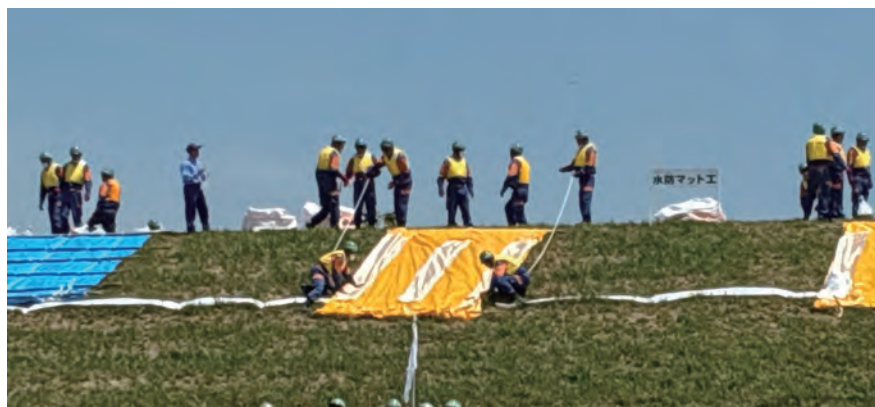
↑ 地元水防団が堤防に水防マット工を行う様子
