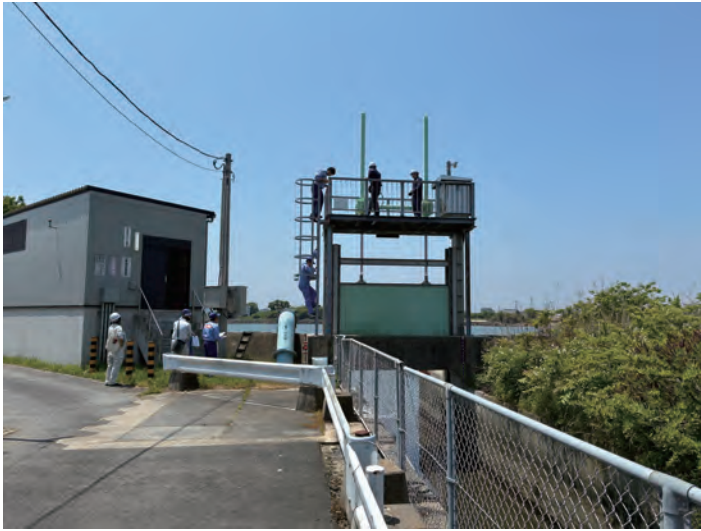
←水門動作確認のため上部に登って確認します。 (栄町水門)
