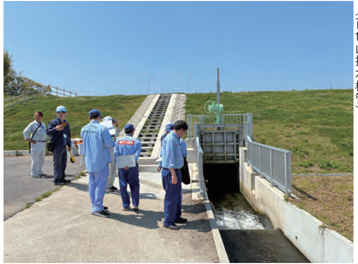
←樋管を確認する常陸河川国道事務所の職員 (白色山排水樋管)
