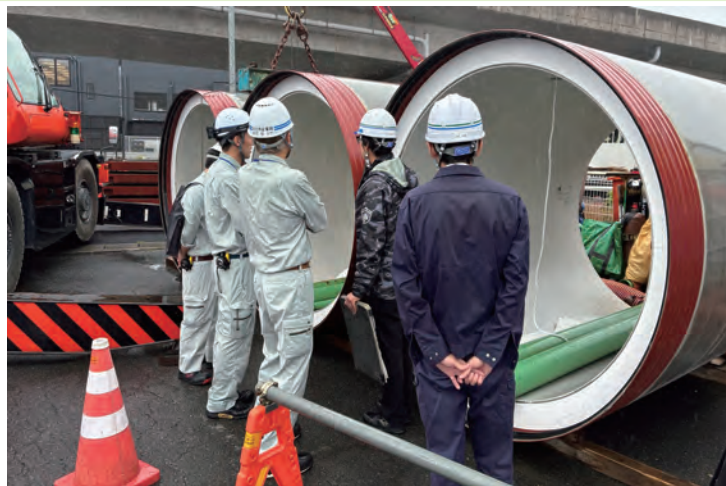
←雨水管の詳細を確認(日立市では近年経験のない工事とのこと。)
