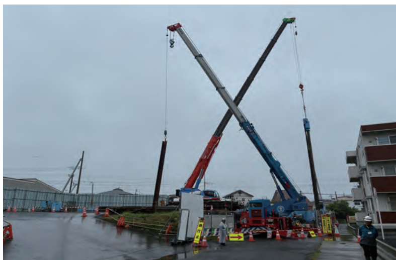
↑施工ヤードの様子（工事箇所）
