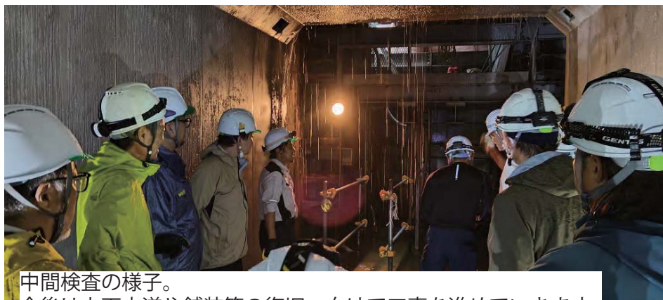
布設したボックスカルバート（箱型の水路）は縦2.8m×横2.8mあります。
