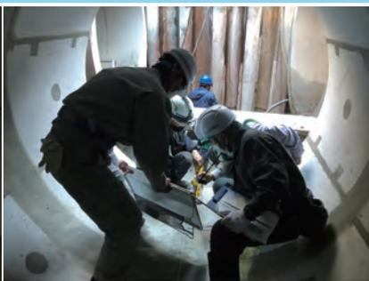
ひたちなか市外野一丁目地内外1箇所の大島第1幹線管きょ布設工事の進捗状況は、令和3年12月15日時点で推進工法により、無事に到達立坑まで施工ができました。推進管が到達したことから推進管の内部の確認を行いました。
