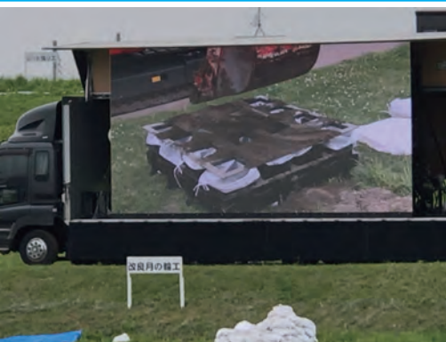
重機による土のう作成状況
