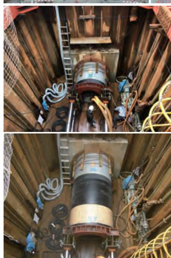
▲上段写真は掘進機の搬入状況、2段目左は掘進機を立坑に搬入した状況、中央は掘進機で掘るための準備、右は掘進機を台座にSETした状況、3段目は管きょを押し込んでいる状況、4段目は特殊管のSET状況。現在約80mの雨水管を布設しました。（令和4年9月上旬現在）
