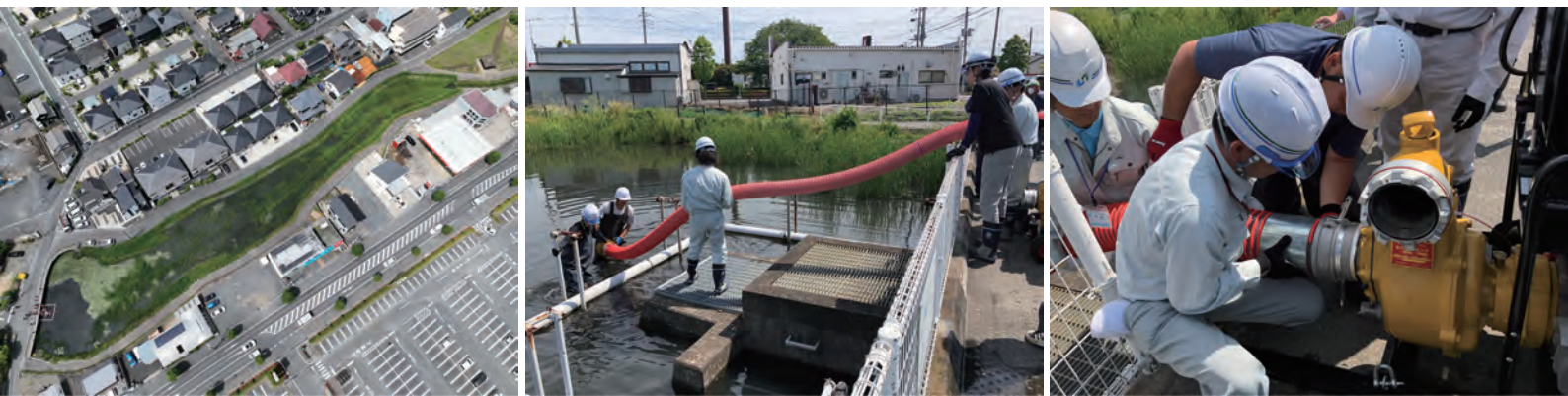
▲上段左から，うなぎ溜の全景→取水ホース設置→可搬式ポンプ設置状況
