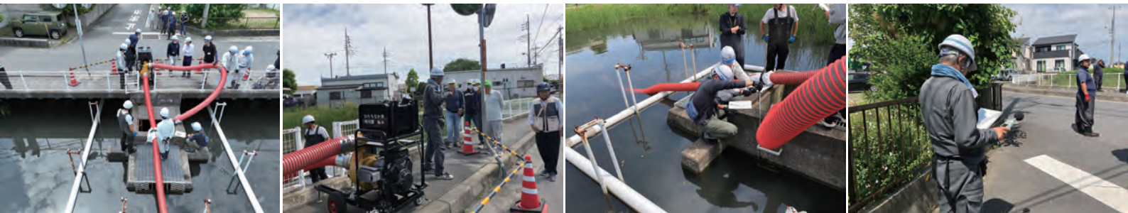
▲下段左から，可搬式ポンプ設置完了→可搬式ポンプ説明→水位観測→騒音観測
