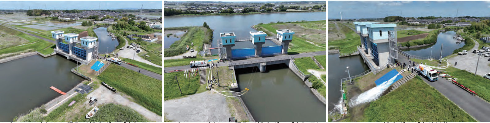
▲水門の下流側から撮影（排水ポンプ車設置）
