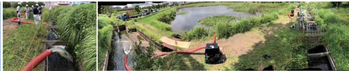
▲上の写真は左から順に、可搬式ポンプ排水の確認状況、事前放流の可搬式ポンプ設置完了と排水状況
