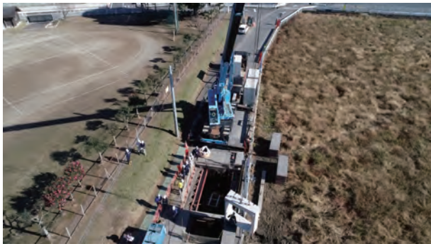
◀▲令和3年度施工状況、左からボックスカルバート布設状況1（上空から）、ボックスカルバート布設状況2、ボックスカルバート布設状況3、ボックスカルバート布設完了
