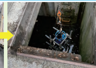
ポンプ確認作業3
