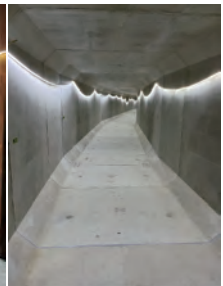
◀▲令和3年度施工状況、左からボックスカルバート布設状況1（上空から）、ボックスカルバート布設状況2、ボックスカルバート布設状況3、ボックスカルバート布設完了
