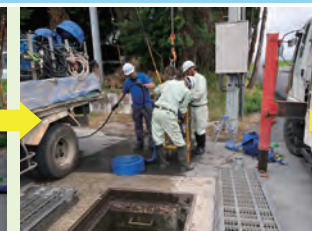
ポンプ確認作業2
