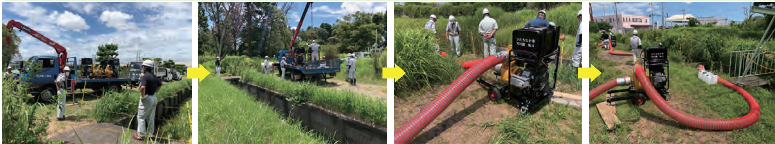
▲上の写真は左から順に、8月12日（金）午前から事前放流の準備を行い、可搬式ポンプを3台設置した状況です。
