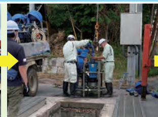
ポンプ確認作業1
