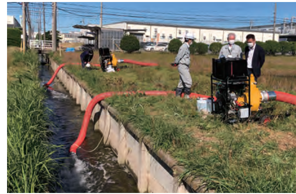
可搬式ポンプ排水状況
