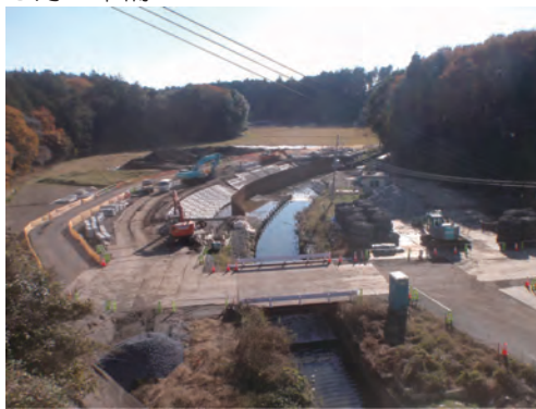
11月：左岸護岸施工
