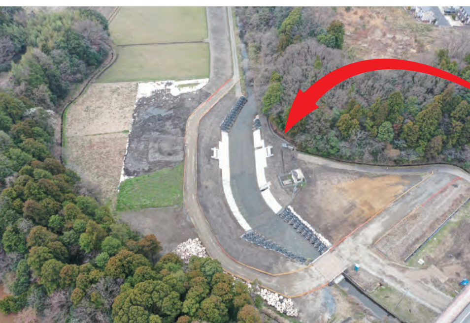
3月完成(下部工)
