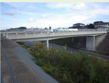
三反田第二跨道橋
