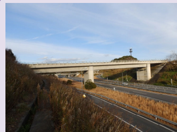
鷹ノ巣跨道橋
