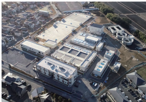
▲新上坪浄水場
