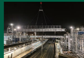
鉄骨組立状況
