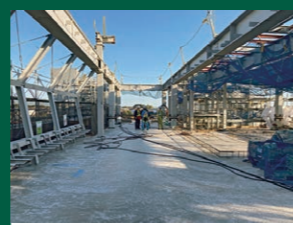
床板打設完了
