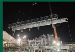
鉄骨組立状況
