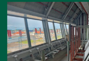
内装工事状況(待合スペース)
