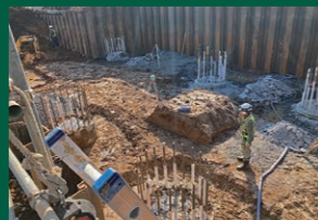
杭設置状況(東口)
