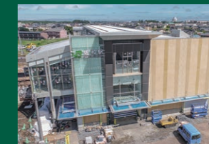
屋根・外装工事完了(西口)
