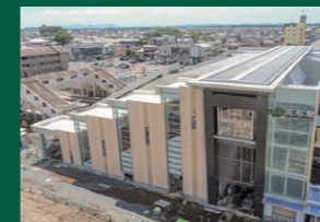
屋根・外装工事完了(東口)
