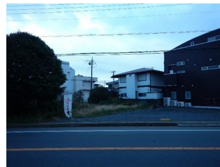
① 変更区間 起点側付近
