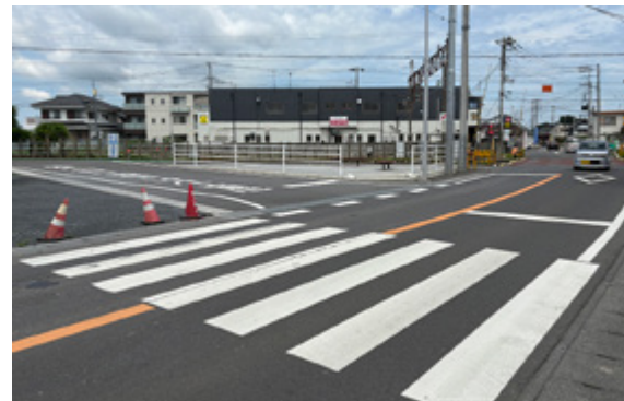
▲湊街道踏切東側の横断歩道
