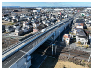
▲4車線化した高場陸橋
