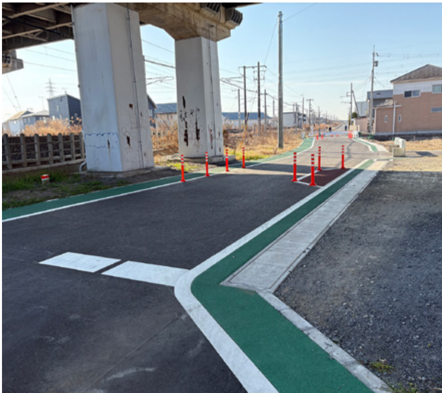
▲車両スピード抑制のため狭窄（きょうさく）を設けた市道佐野地区563号線（延長67m，幅員6m）
