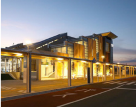
▲東口側外観 (夜間)
