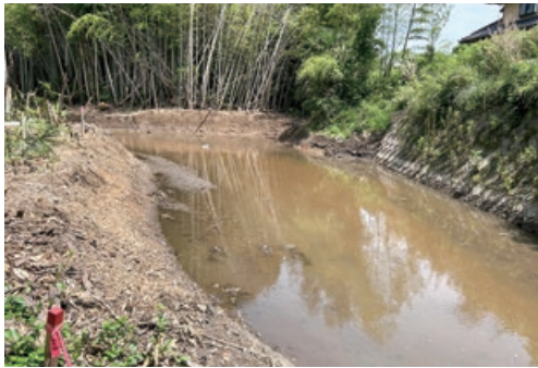
しゅんせつ 浚渫・伐採後の鳴戸川の様子
