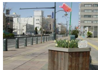
電線地中化の施された昭和通り線
