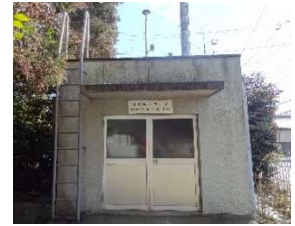
市役所敷地内の大気測定局
