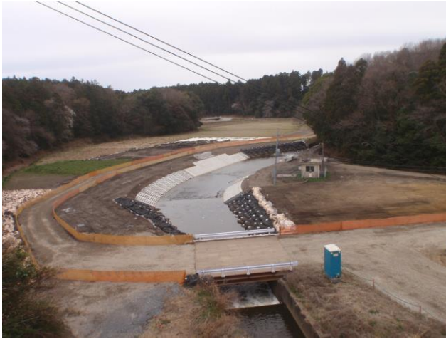
大川における河川整備の様子
