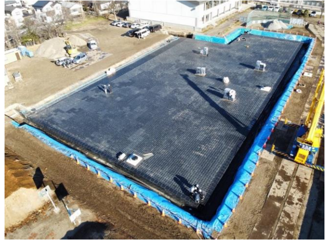
雨水貯留施設整備の様子
