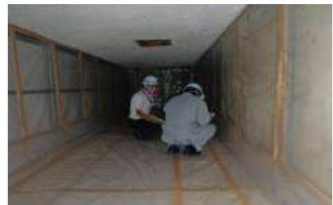
石綿(アスベスト)対策立入調査の様子
