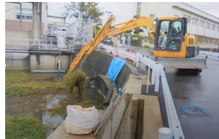
重機による駆除事例
