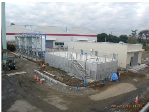
建設中の上ヶ砂配水場水処理施設
